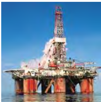
Korrosionsschutz von Offshore-Bauten erfordert robuste Technik.
